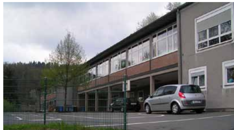
Grundschule in Wehbach
